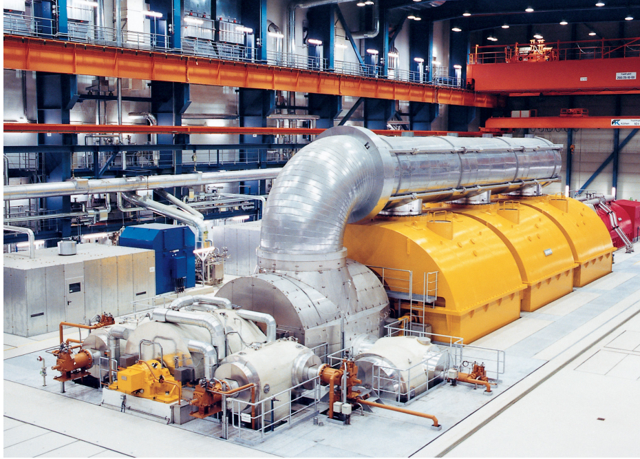
Rys. 5.5 Turbozespól 750 MW
