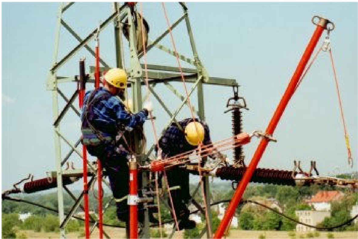
I przykład pracy wykonywanej na nie wyłączonej linii wysokiego napięcia
