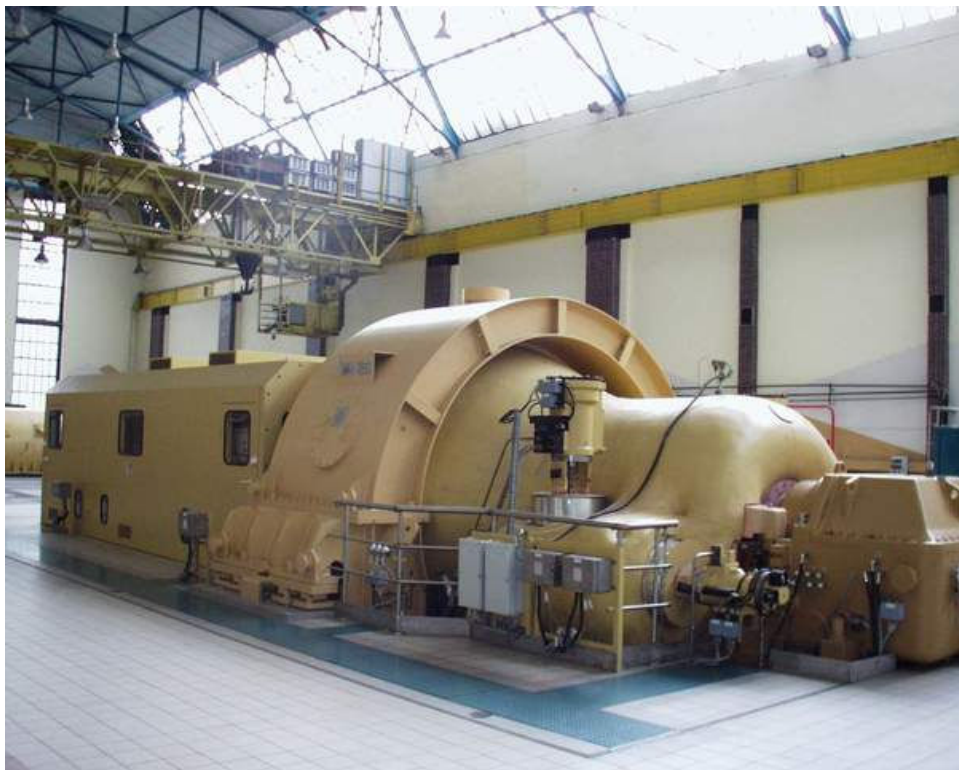
Rys. 5.3 Turbozespół 65 MW
