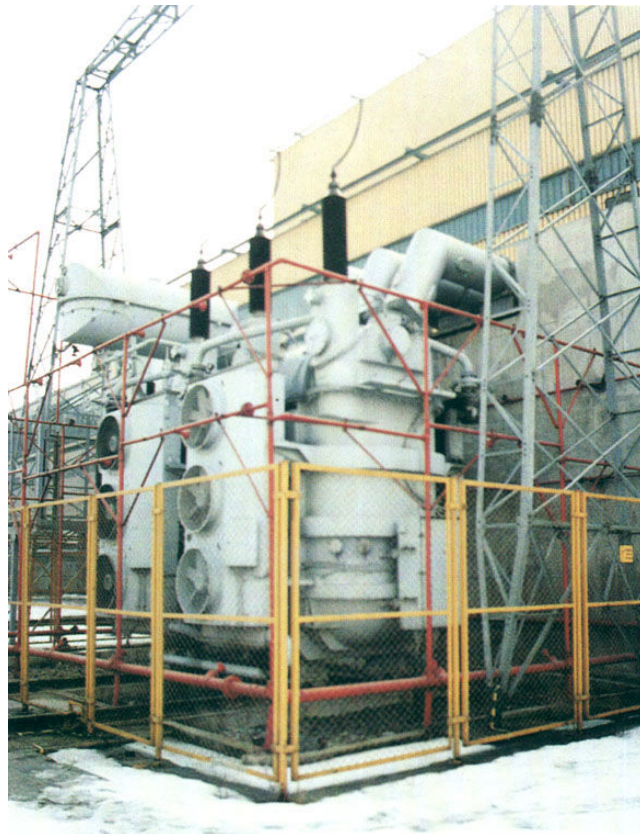
Rys. 5.6 Transformator blokowy: 150 MVA, 13,8kV / 125kV (6280A / 675A; masa: 111 ton)
